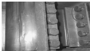
图8 螺栓松动引起的发热缺陷
