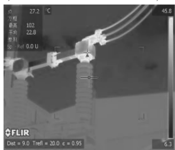
图6 00140开关发热红外照片
